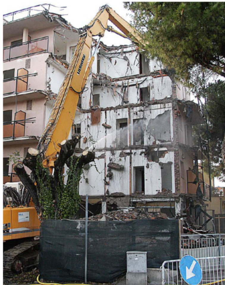
La demolizione di un hotel
